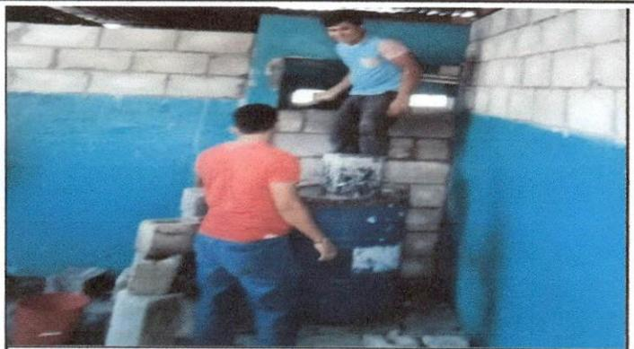
Foto 14: Reparación de muro perimetral de block.
