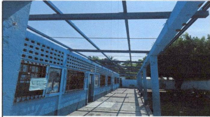
Foto 13: Reparación de columnas en mal estado.
